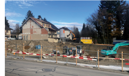
Aushub Neubauprojekt St. Urs, Biberist
